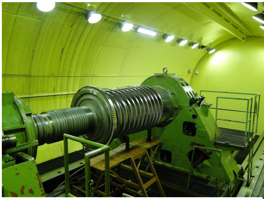
Wirnik na stanowisku w odwirowni Zamechu, hala A20
