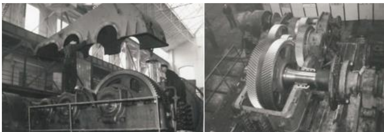
Montaż przekładni zębatych na Wydziale W5
